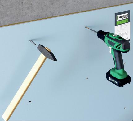
Шляпка саморезов утапливается в теле звукоизоляционного гипсокартона на 1 мм. Расход составляет 22 шт./м<sup>2</sup>
