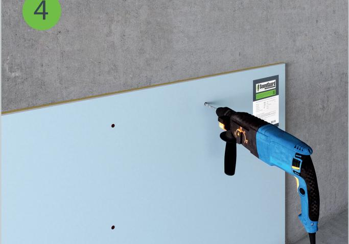
Крепление звукоизоляционного гипсокартона к стене осуществляется универсальными саморезами SoundGuard YH 4x80 с дюбелями SoundGuard DR 6x60 с предварительным засверливанием.
