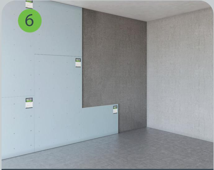
Звукоизоляционный гипсокартон монтируется совместно с мембраной и крепится к стене без зазоров между листами.
